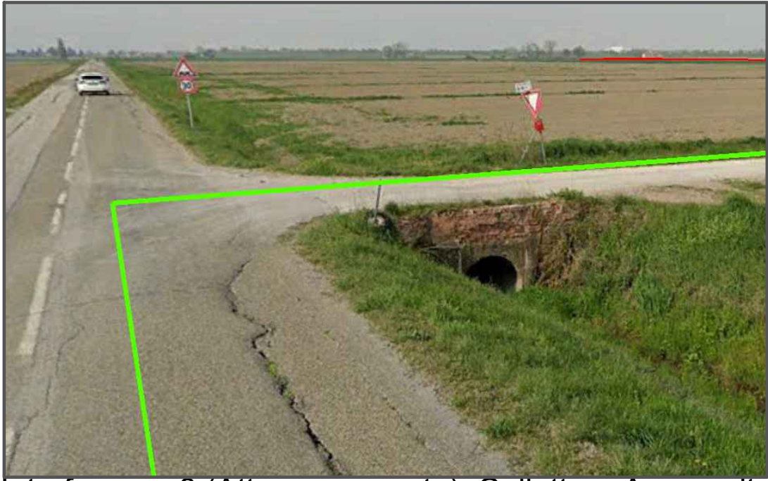
Interferenza 8 (Attraversamento): Collettore Acque alte Risoluzione: Staffaggio su ponte
